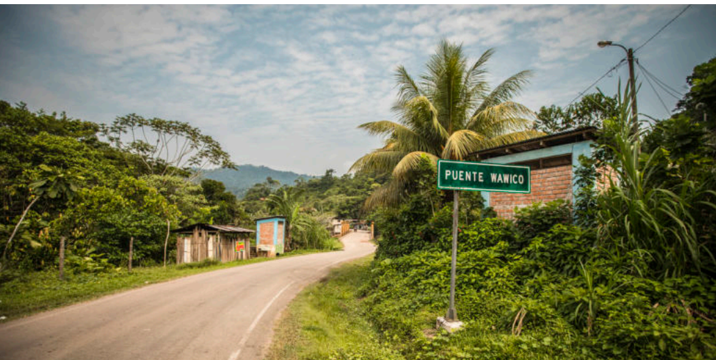
Puente Wawiko, Amazonas.
