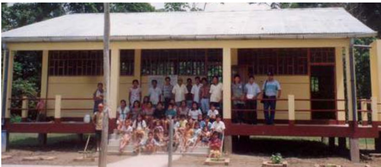
CEP N°60322 en la comunidad de Nuevo Cajamarca, Napo, Loreto, construido en el marco del Programa Frontera
