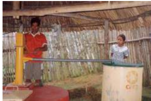
Sistema manual de bombeo de agua CN Copal Yacu. Napo, Loreto
