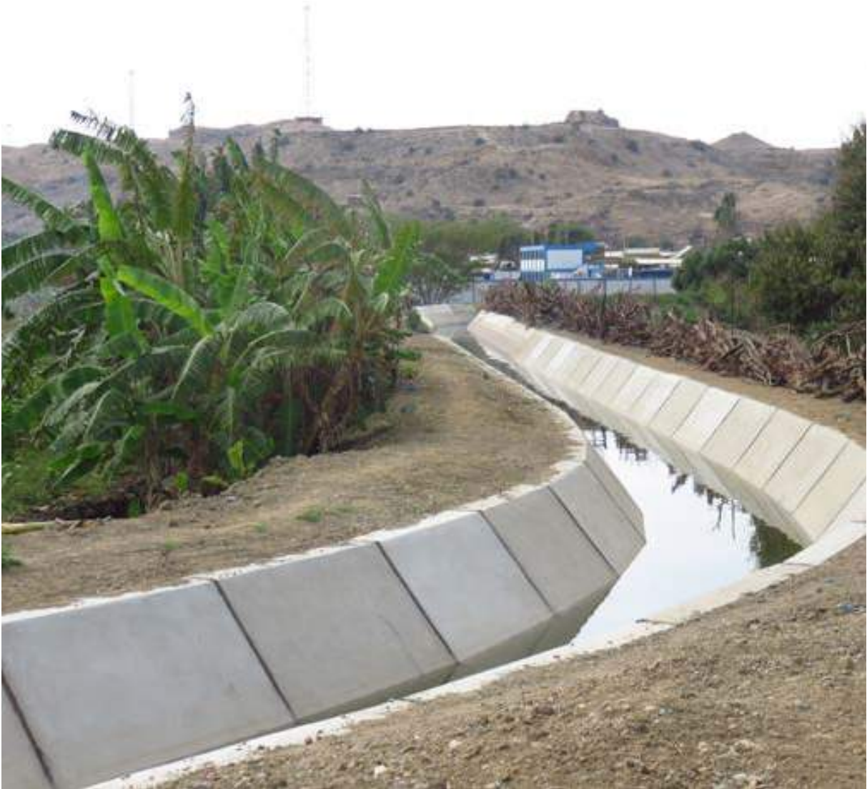
Canal de riego San Jorge. Amotape, Paita, Piura
