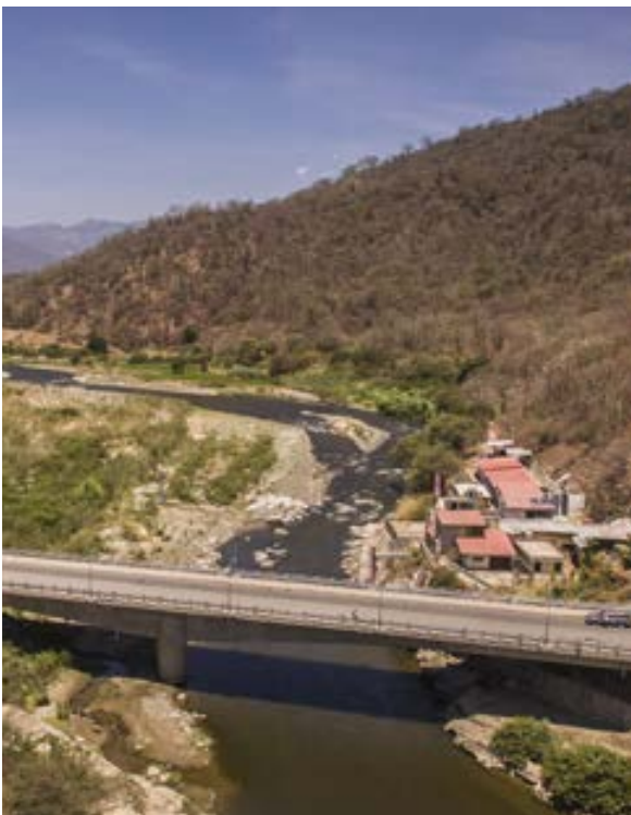
Eje Vial N° 3, Vista del Puente Internacional de La Amistad
