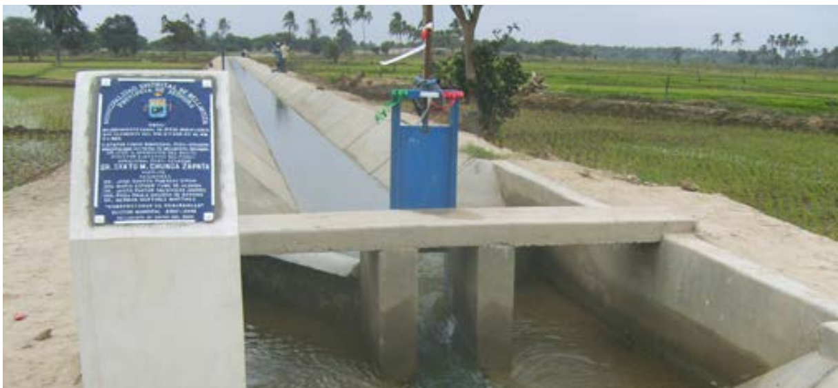
Canal de riego Miraflores - San Clemente. Bellavista, Sechura, Piura
