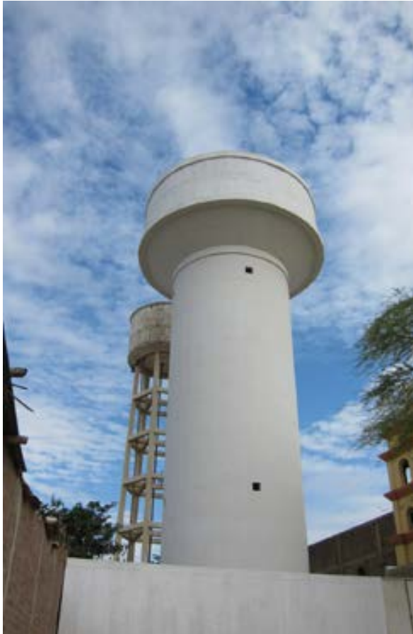
Pozo de agua en Cucungurá, Cura Mori, Piura, financiado por el Gran Ducado de Luxemburgo y el Ministerio de Vivienda, Construcción y Saneamiento
