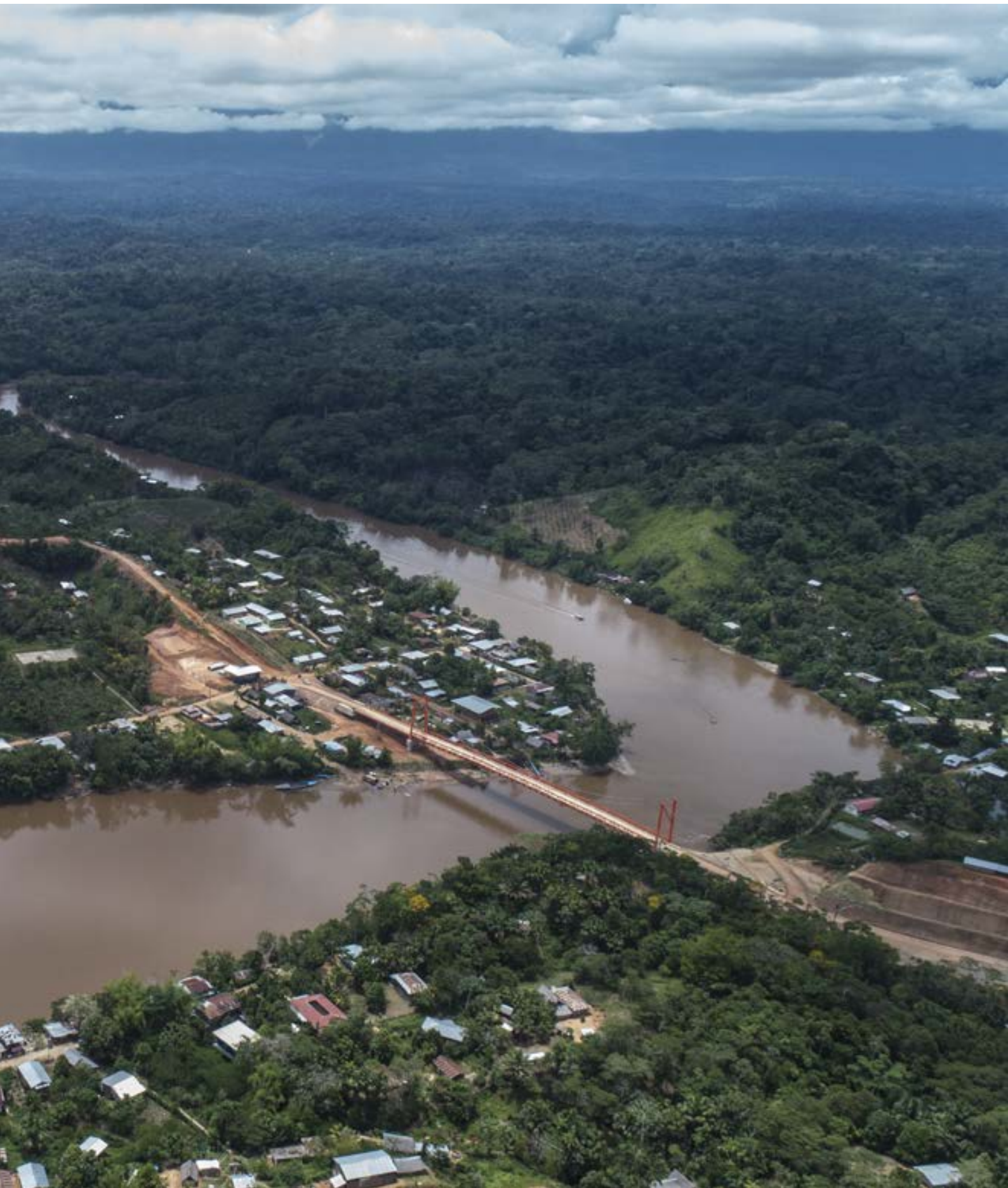
Vista aérea de los barrios de Juan Velasco Alvarado y La Tuna de Santa María de Nieva. Condorcanqui, Amazonas.
