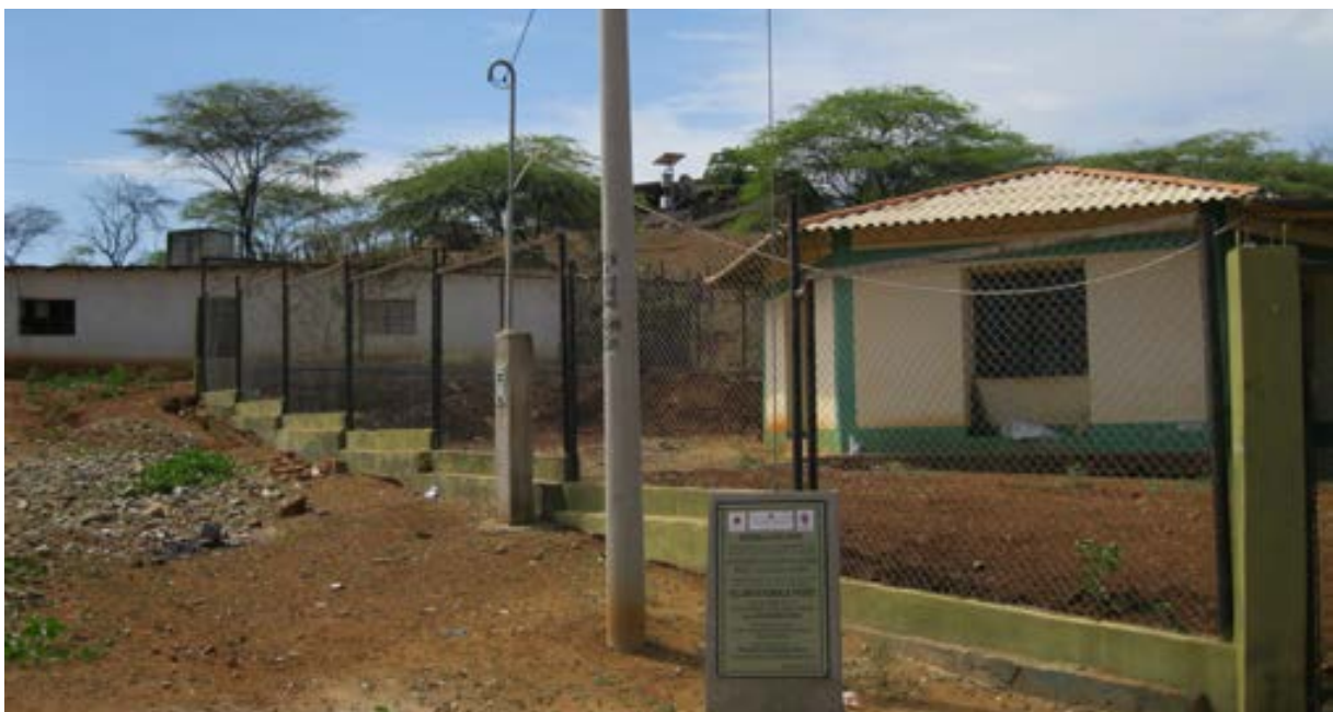
Interconexión eléctrica vecinal en Suyo, Ayabaca, Piura financiada por el Gran Ducado de Luxemburgo y el Ministerio de Energía y Minas
