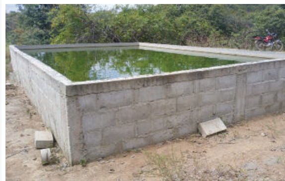
Estanque de concreto - comunidad Pampa Larga.
