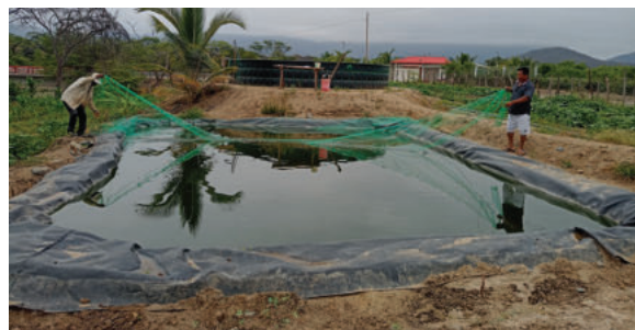
Estanque de tierra recubierto con geomembrana - comunidad La Tina.
