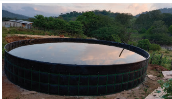
Estanque circular de geomembrana (geotanque).
