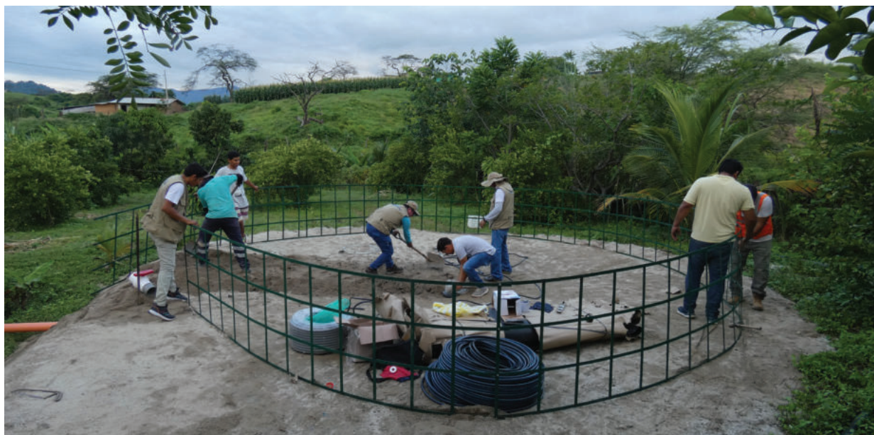
Instalación de geotanque - comunidad la Tina.
