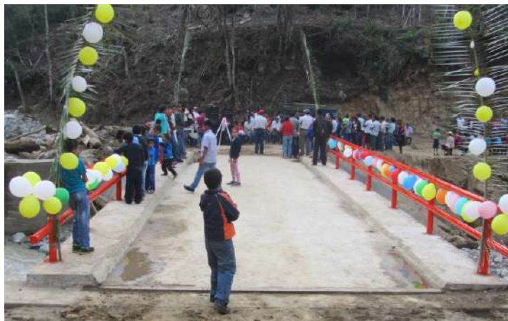
Con esta obra se han visto beneficiadas más de 2500 personas en La Palma del Páramo y los caseríos aledaños.
