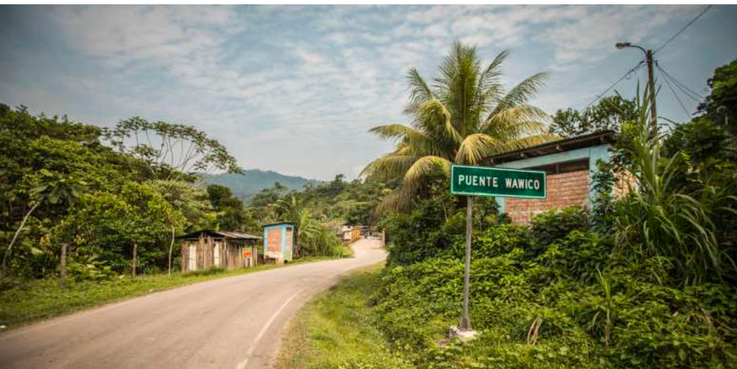
Puente Wawiko, Amazonas.
