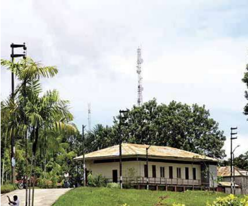
Instalaciones de comunicaciones en Loreto, del Proyecto de Integración Amazónica del Ministerio de Transportes y Comunicaciones
