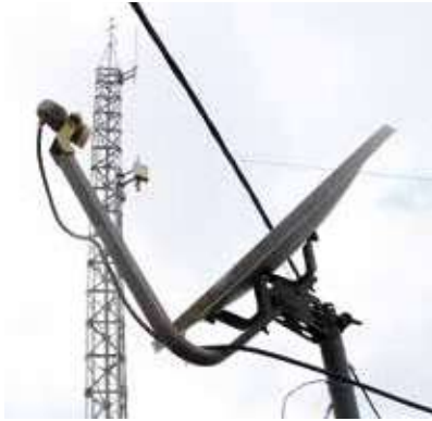
Estación base de telefonía móvil en Piura
