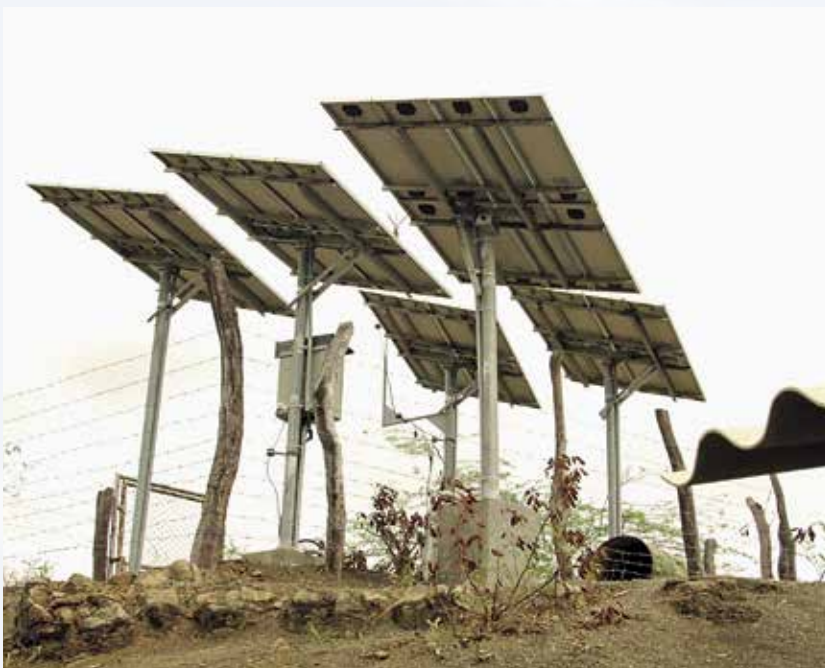
Pozo de agua en la localidad de La Matanza, Piura, financiado por Luxemburgo y el Ministerio de Vivienda, Construcción y Saneamiento
