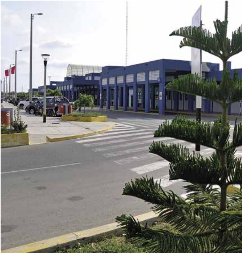
Centro Binacional de Atención en Frontera en el Eje Vial N° 1 Piura-Guayaquil, cabecera Perú, cofinanciado por la Comunidad Europea y el Ministerio de Transportes y Comunicaciones
