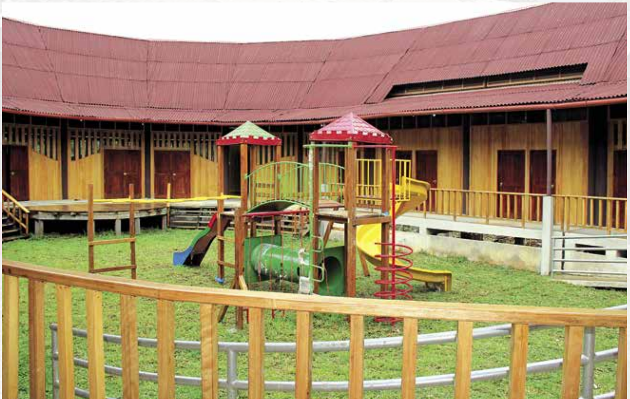
Institución Educativa Inicial en Campo Serio, distrito de Torres Causana, Loreto, cofinanciada por el Fondo Binacional
