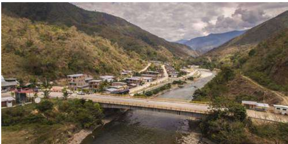
Eje Vial N° 4, Vista del Puente Internacional Integración.
