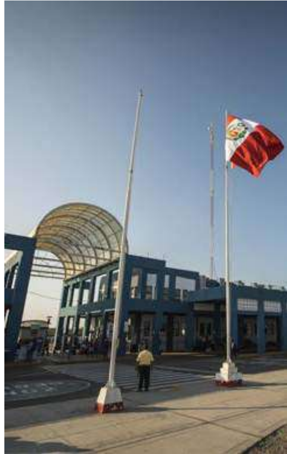
Eje Vial N° 1, Vista del Centro Binacional de Atención en Frontera. Tumbes
