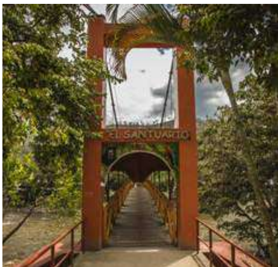
Vista del Puente peatonal El Santuario. Namballe, San Ignacio, Cajamarca
