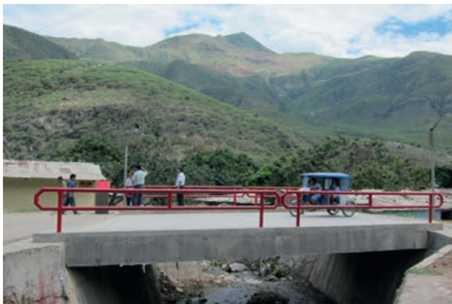
Puente carrozable Pucará. Jaén, Cajamarca
