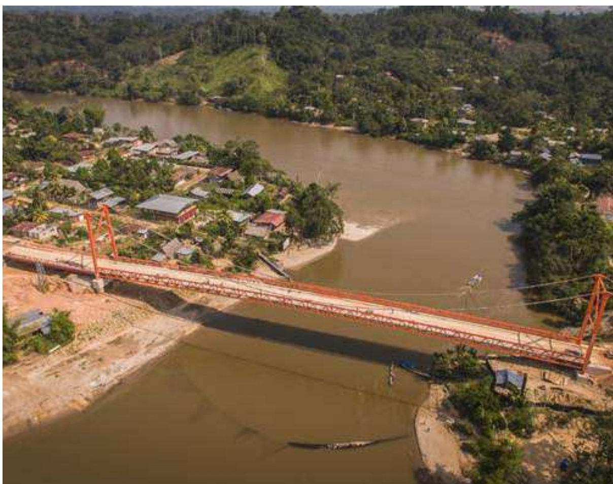
Vista aérea del puente Santa María de Nieva. Condorcanqui, Amazonas.
