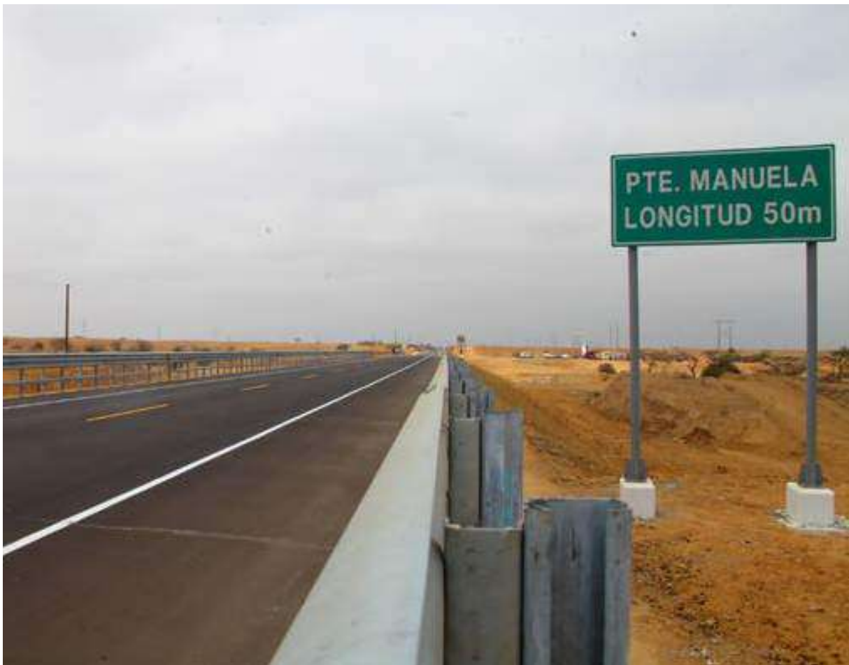
Eje vial N° 1, Vista del Puente Manuela en Piura.
